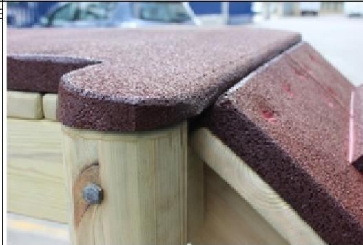
5° Avec de la silicone de la même couleur que le sol, sceller les jointes et recouvrir les têtes des vis.
