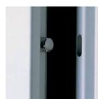
Feuillure des portes à double chicane, pènes inaccessibles par imbrication des portes à la fermeture.
