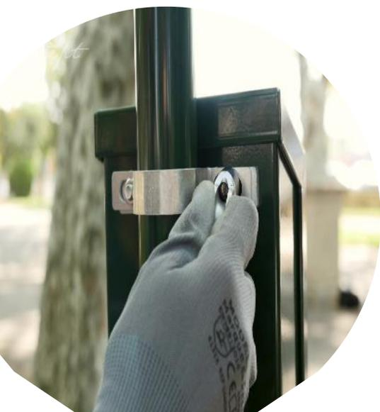
Installation du haut de mât et du distributeur sur le mât à l'aide des 3 colliers fournis
