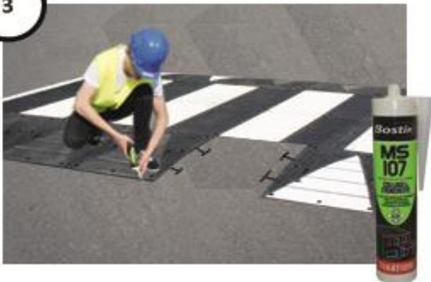
Appliquez une colle polymère RQ GLUE (en option - non fournie) sur la périphérie de chacun des éléments sur une bande de 10 cm de large (conseillé pour une meilleure résistance à l'eau, gel ...). Lors de la pose la température doit être comprise entre +1°C et +30°C.
