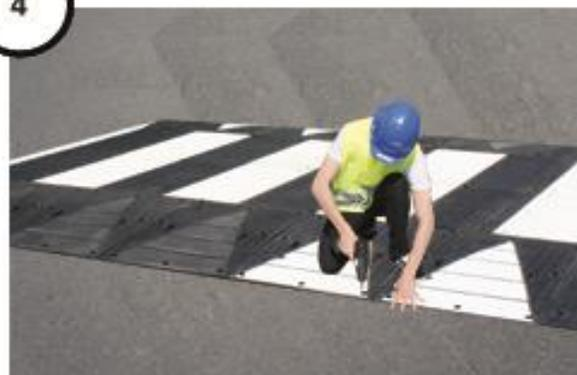
Une fois le ralentisseur bien positionné, percez au travers des éléments un trou  $\varnothing$  11/12 mm (11mm pour les matériaux dur) puis insérez votre cheville sans bouger le coussin. Vissez fortement votre tirefond avec sa rondelle.
