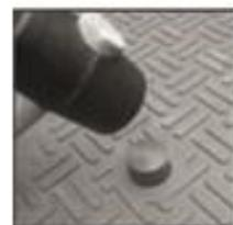
Fermez les trous avec les bouchons et, si besoin, aidez vous d'un mallet pour la mise à niveau.
